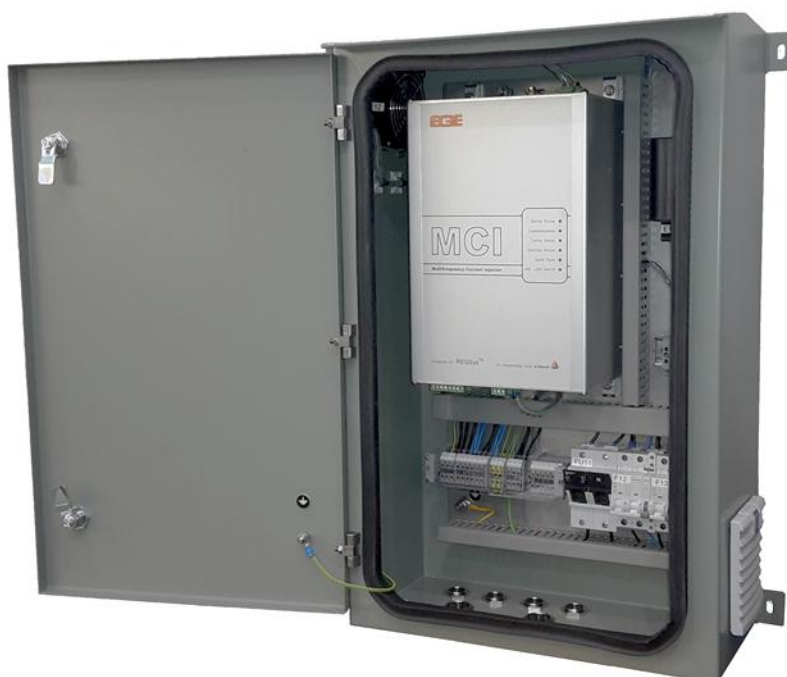
Obr. 7: Příklad MCI P-01 v samostatné skříni pro dodatečnou instalaci na tlumivku.
